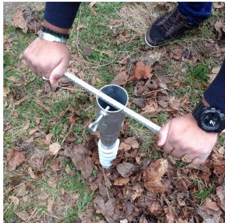
ÉTAPE 3 : lorsque la vis d'ancrage est enfoncée à moitié, corriger sa verticalité
